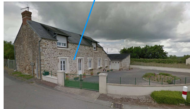
Habitations anciennes mais rénovées
