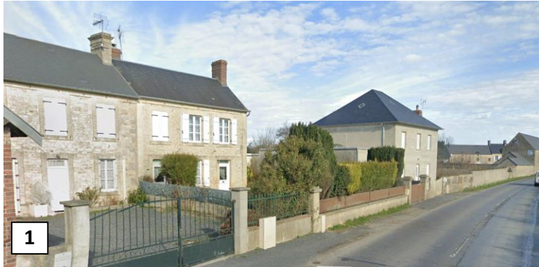
Habitations le long de la RD 517
